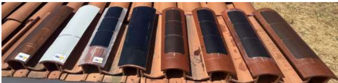
Figura 5 Instalación en cubierta de los elementos BIPV desarrollados con diferentes acabados superficiales.
