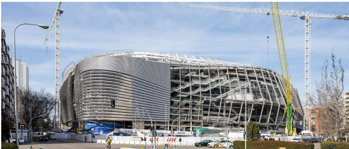
Figura 1. Vista exterior este del Estadio Santiago Bernabéu en construcción en un entorno urbano, mostrando la fachada tridimensional de lamas y la subestructura que cuelga de la cubierta.
