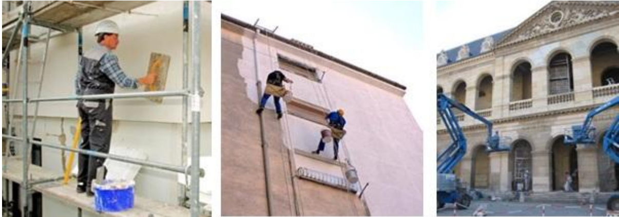
Figura 1. Trabajos en fachadas
