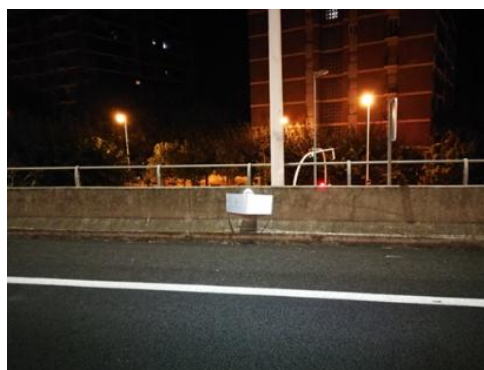
Figura 7. Detalle de instalación de sensores de calidad del aire con medición en continuo en la C-31
