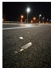
Figura 5. Colocación “in situ” de probeta-testigo, en la zona del arcén, antes de la aplicación del tratamiento fotocatalítico
