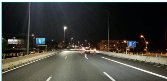
Figura 1. Estado de la Autopista C-31 durante la aplicación del tratamiento fotocatalítico, el 11 de agosto de 2023
