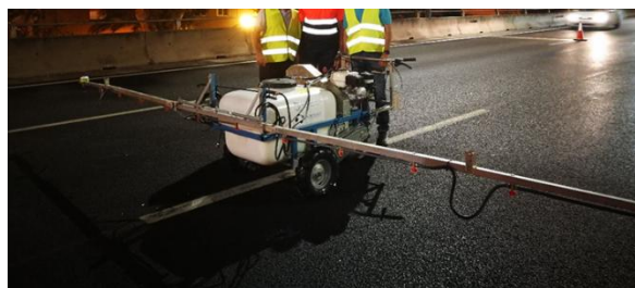
Figura 3. Sistema de aplicación del tratamiento fotocatalítico en la Autopista C-31
