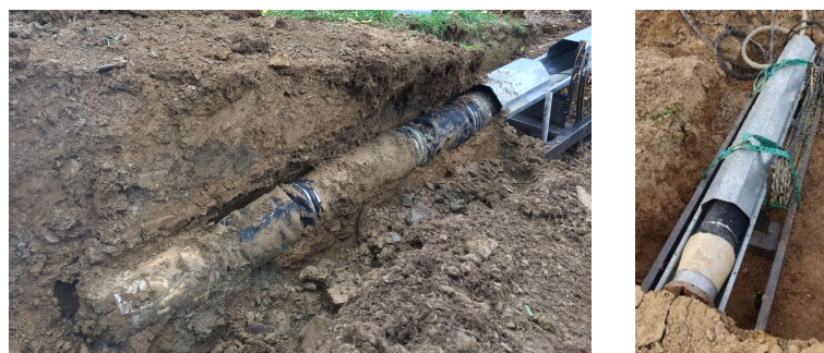
Figura 5. Pruebas de perforación en Alemania (izquierda) y España (derecha)
