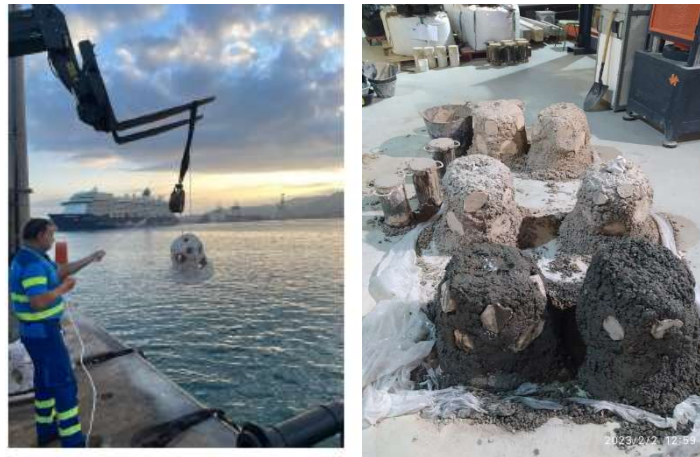
Figura 2. Diseño e instalación de los arrecifes
