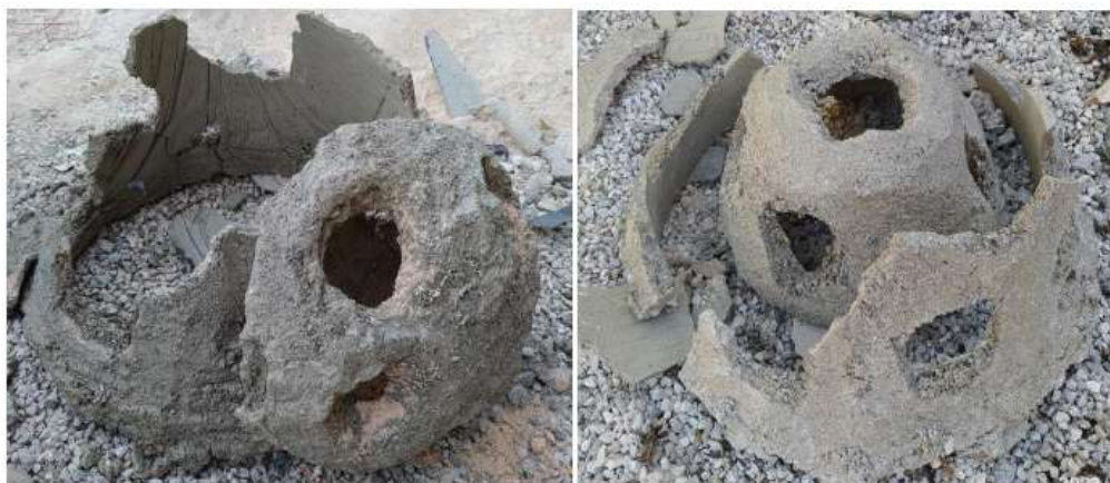
Figura 1. Problemas durante la ejecución del primer diseño
