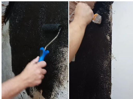
Figura 3. Fotos de la aplicación de la pintura anti-radón con brocha y rodillo en el hueco de la escalera intervenido.
