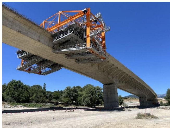
Figura 6. Ejecución de voladizos laterales con carro de alas (viaducto de Sabiñánigo)
