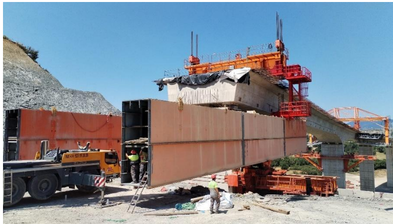
Figura 8. Conclusión del desmontaje con viga de cuelgue móvil [2]
