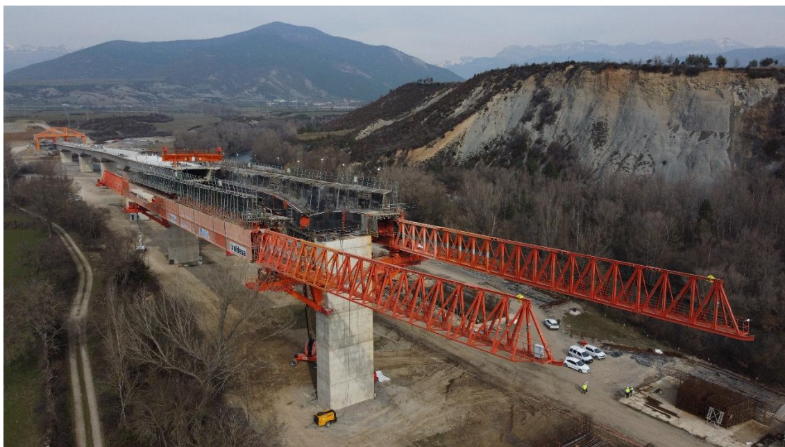
Figura 1. Autocimbra Zamora II en operación en Sabiñánigo
