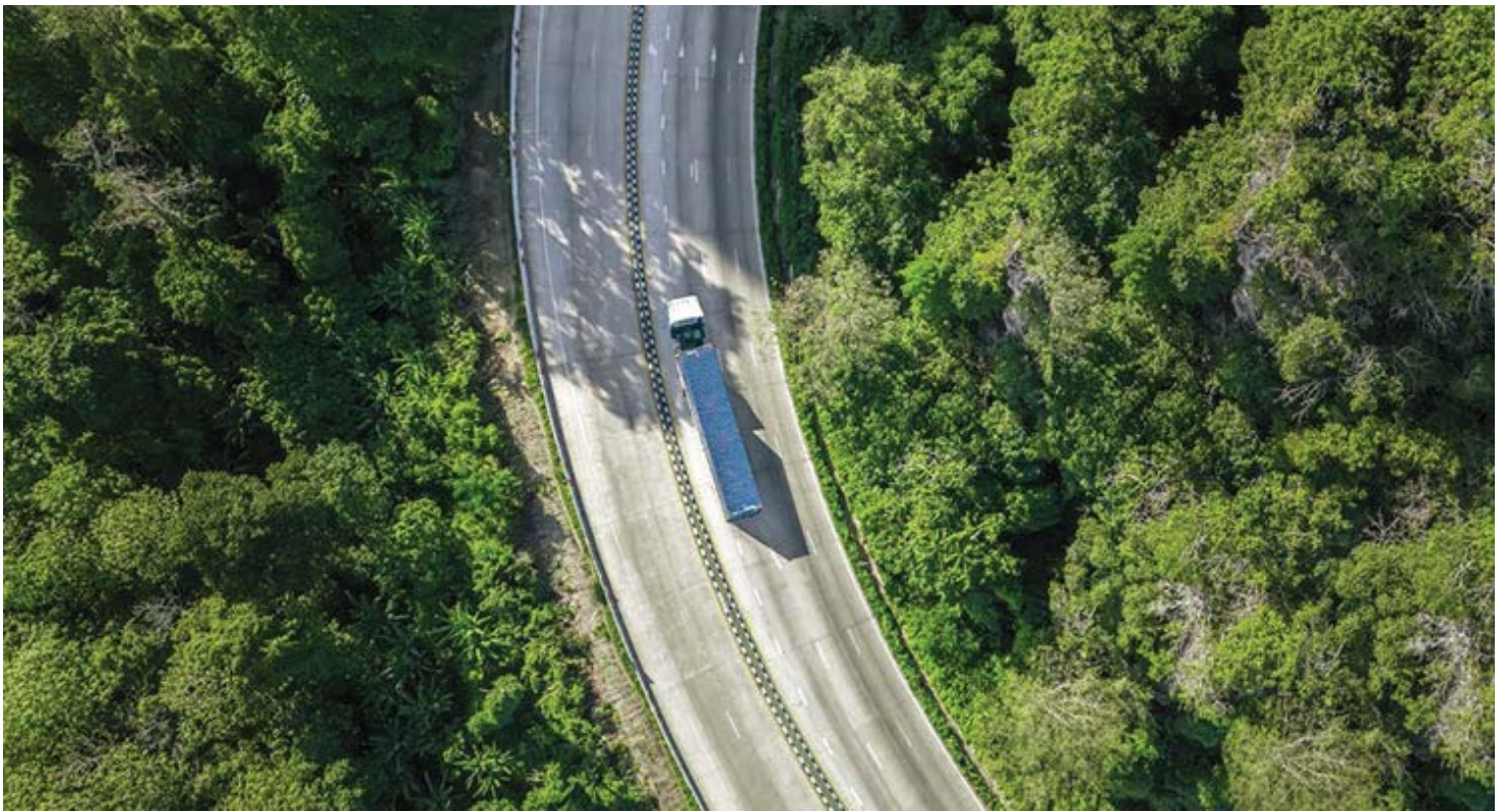
El 52% de la infraestructura vial presenta deterioros graves y un 32 % de los trazados –34.000 kilómetros– requiere una intervención integral, según la AEC.
